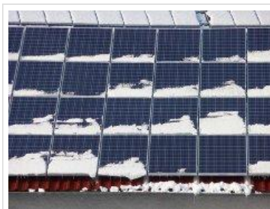
Photovoltaik Reinigung © Zauberhut, fotolia.com
